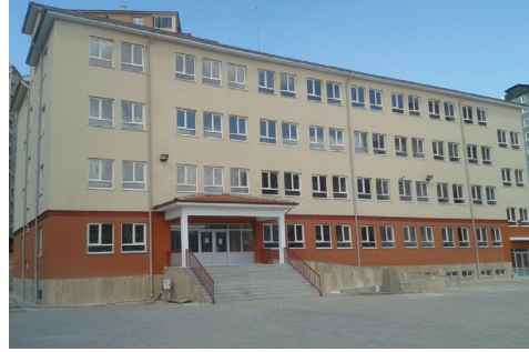
Yozgat'ta yapılan MEV ilkokul-orta- okul binası
