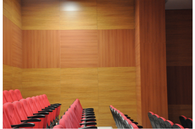
Konferans Salonu Akustik Kaplama Yapımı
