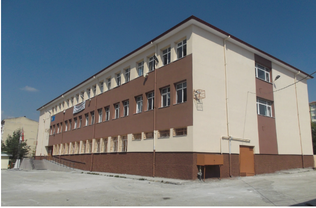
Ankara Mamak'taki Kuvayi Milliye Ortaokulu'nun dış cephe onarımı
