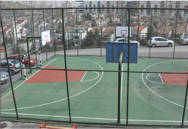
Basketbol Sahasının Yenilenmesi
