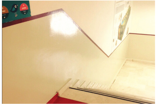
Tadilat ve Boya Yapımı
