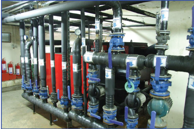
Kazan Dairesi Bakım Onarımı
