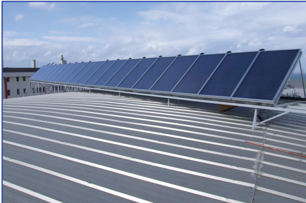
Güneş Enerjili Kapalı Havuz Isıtma Sistemi Yapımı
