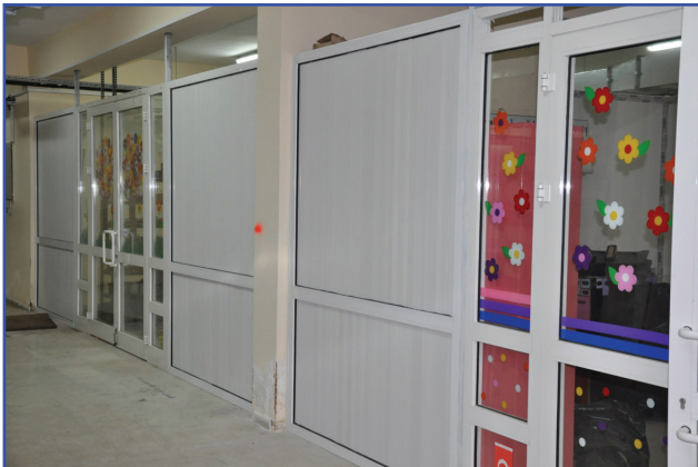
PVC Kapi,Oda Kilidi ve Lambiri Kaplama Yapımı
