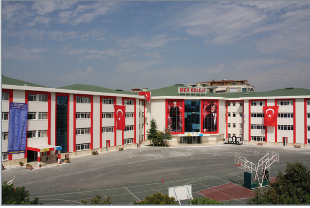
Dış Cephe Kaplama
