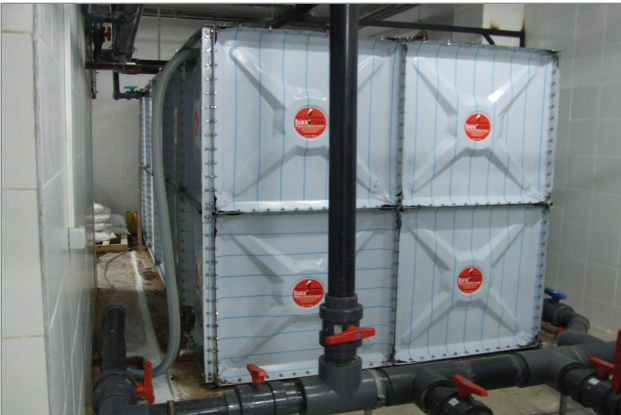
Havuz Denge Tankı Yapımı
