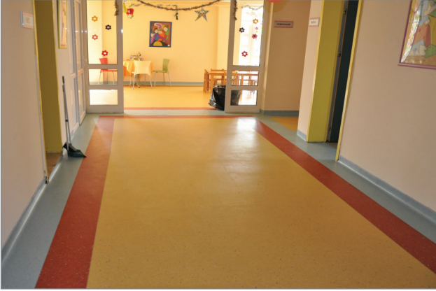
Anaokulu Zemin PVC Kaplama Yapımı
