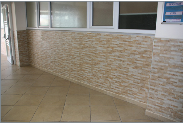
Yer ve Duvar Fayansları Yapımı
